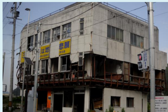
大きな被害を受けたまま残る建物
